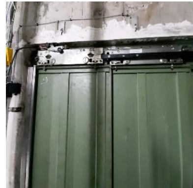
Serrure de porte palière du niveau principal
