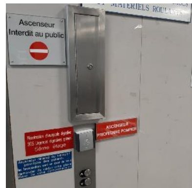
Commande palière du niveau principal
