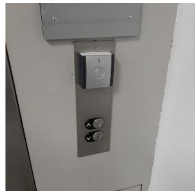
Commande palière du niveau principal
