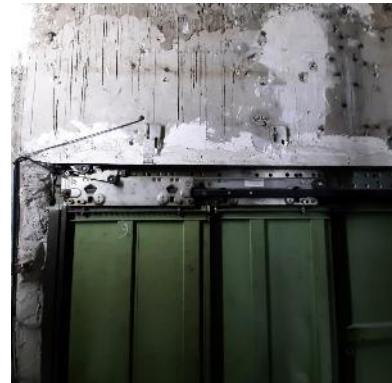
Serrure de porte palière du niveau principal
